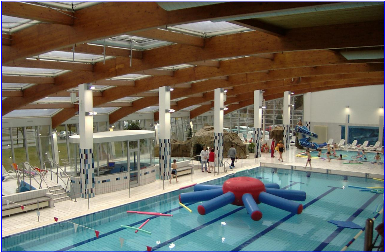
Schwimmerbecken, dahinter Nichtschwimmerbecken mit Rutsche und Lichtgrotte
