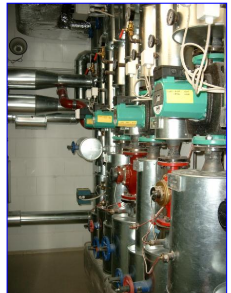
Heizungsverteiler
