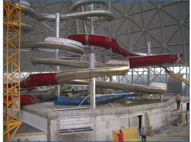
Rutschenkonstruktion während der Montage
